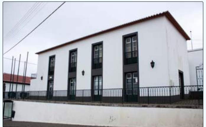
Trabalhos de pintura na Casa do Povo
