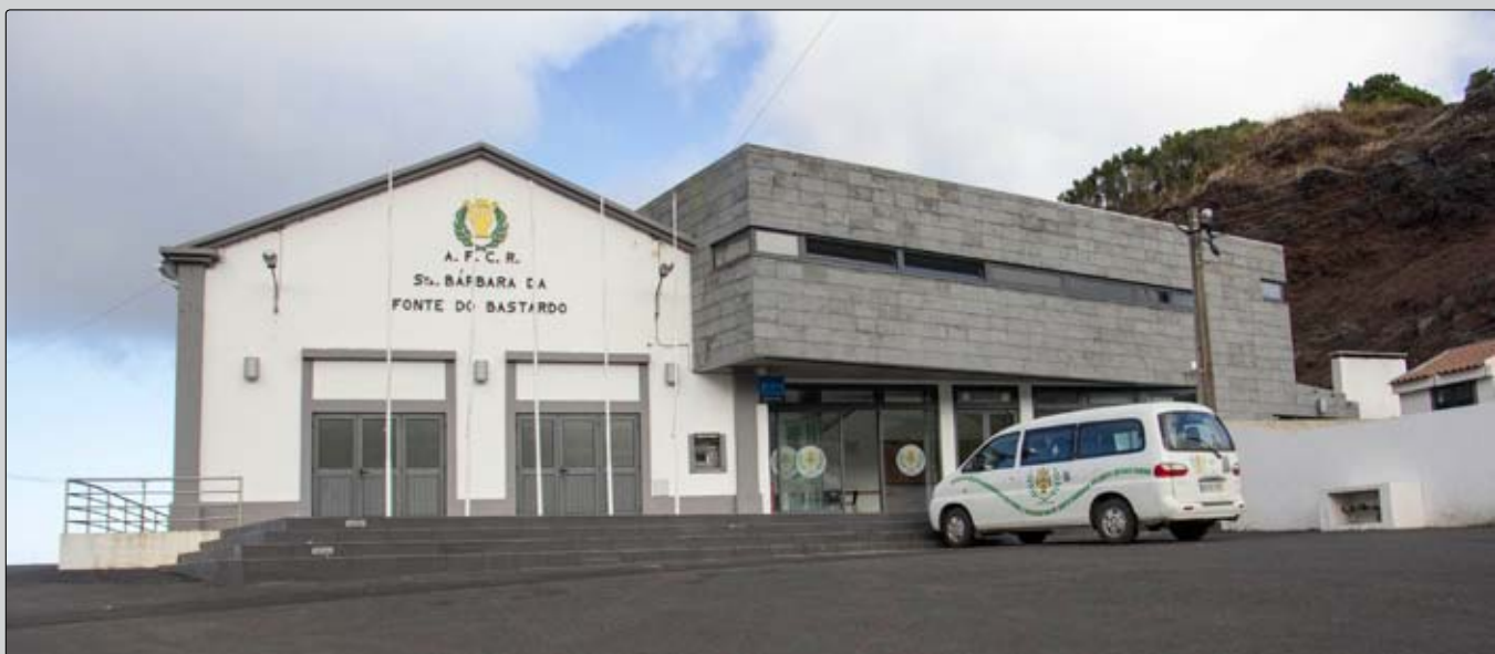
Remodelação e ampliação do Salão da Filarmónica
