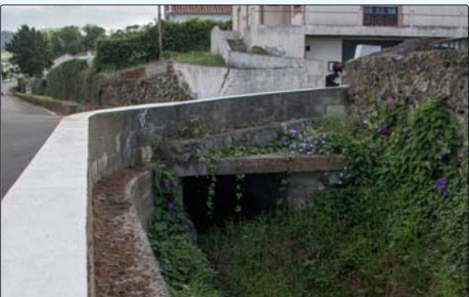
Requalificação do aqueduto na Canada da Bica
