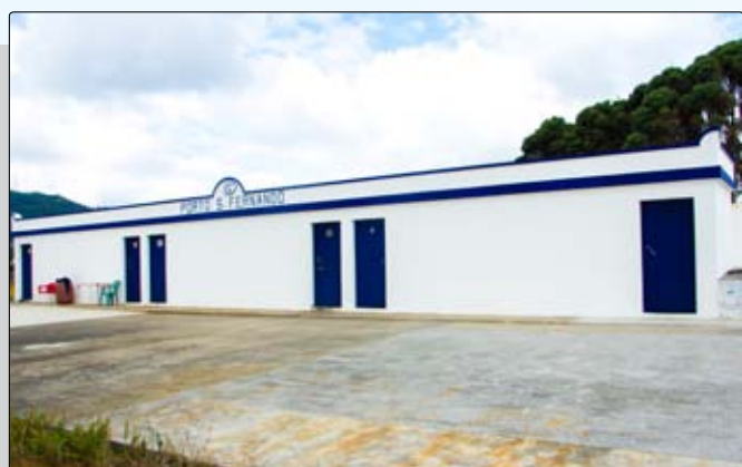
Alteração da fachada das casas de aprestos do Porto de São Fernando
