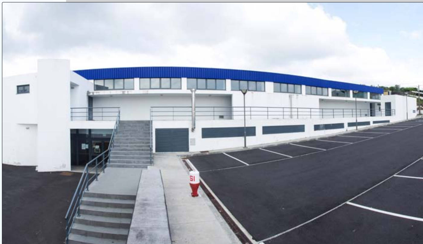
Construção do Pavilhão Desportivo do Porto Martins
