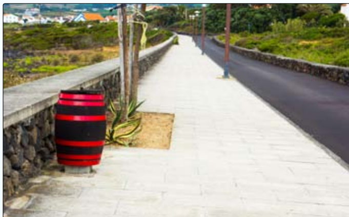
Colocação de papeleiras no Passeio Marítimo
