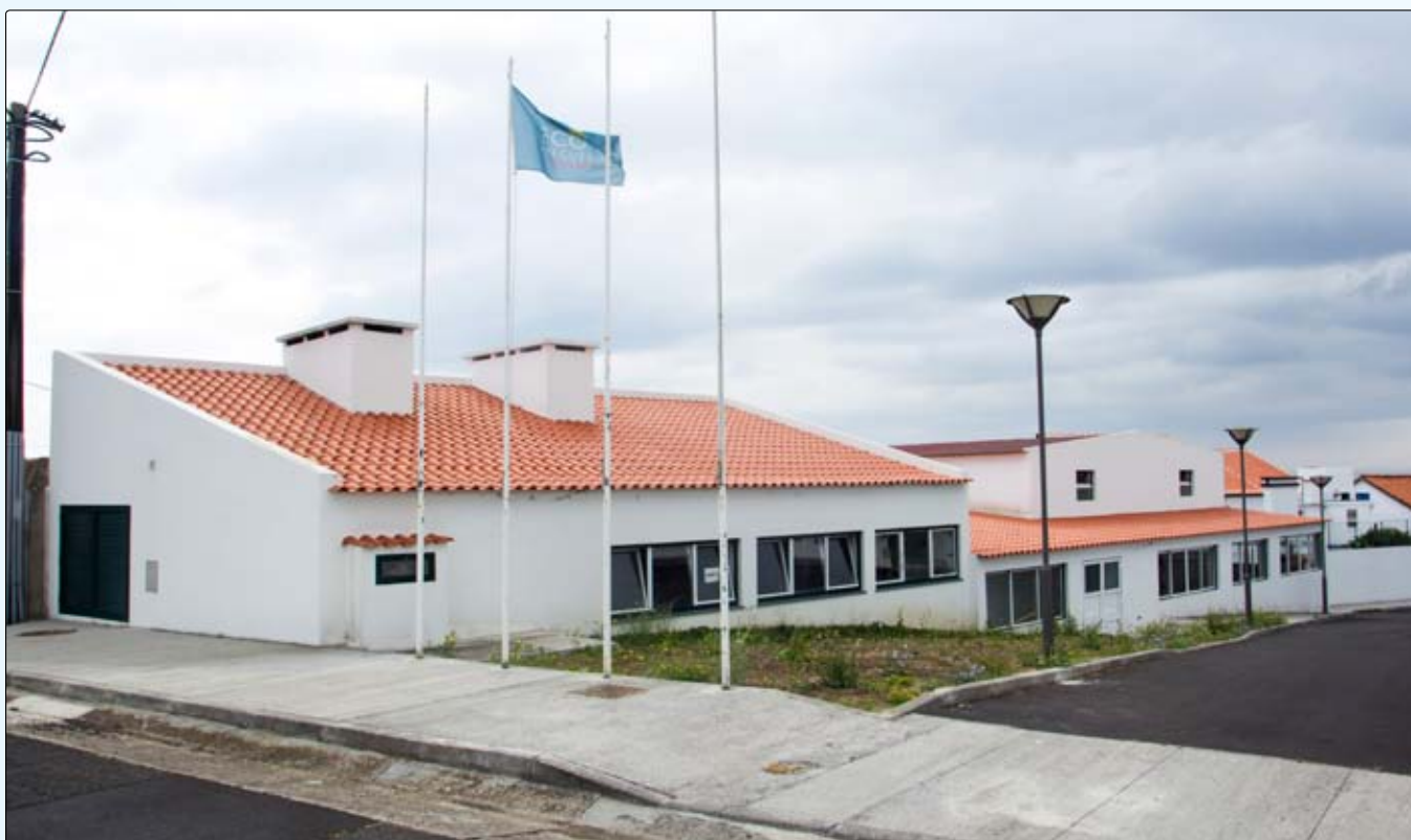
Construção da Cozinha Regional no edifício do Salvão de Festas
