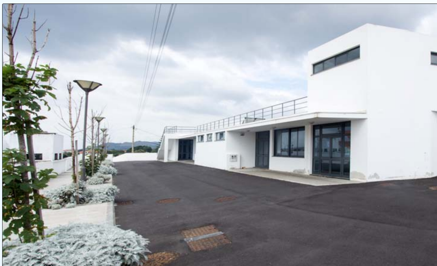
Construção do Edifício Multiserviços do Porto Martins
