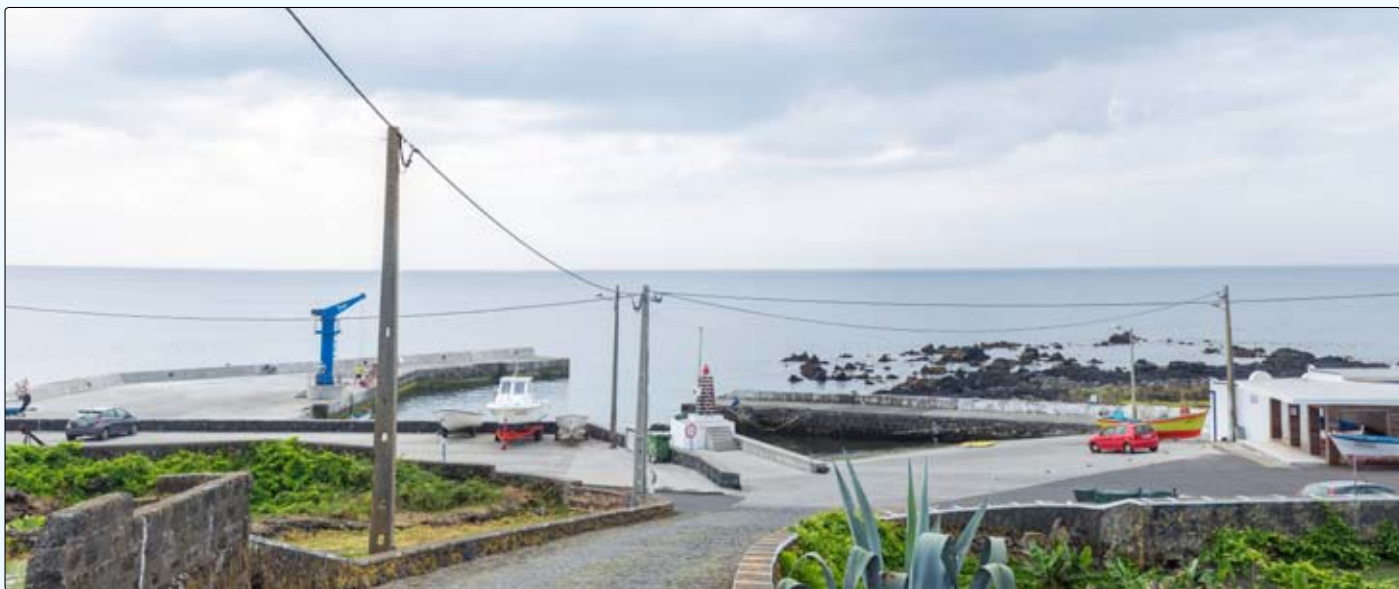
Obra de construção do molhe de proteção do Porto de São Fernando
