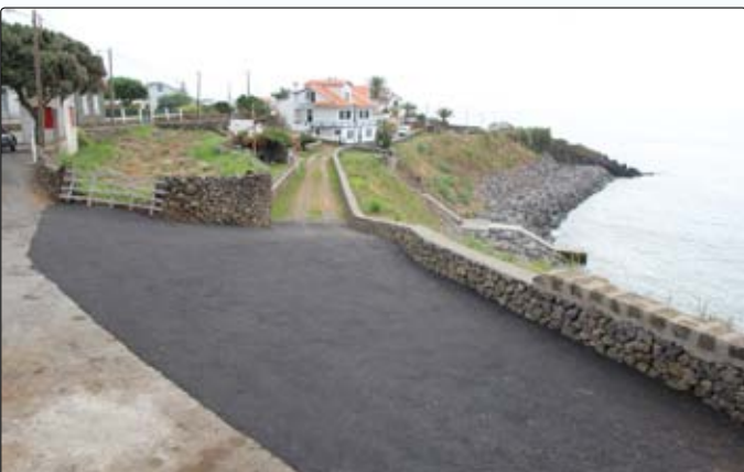
Pavimentação da entrada do Caminho da Rocha
