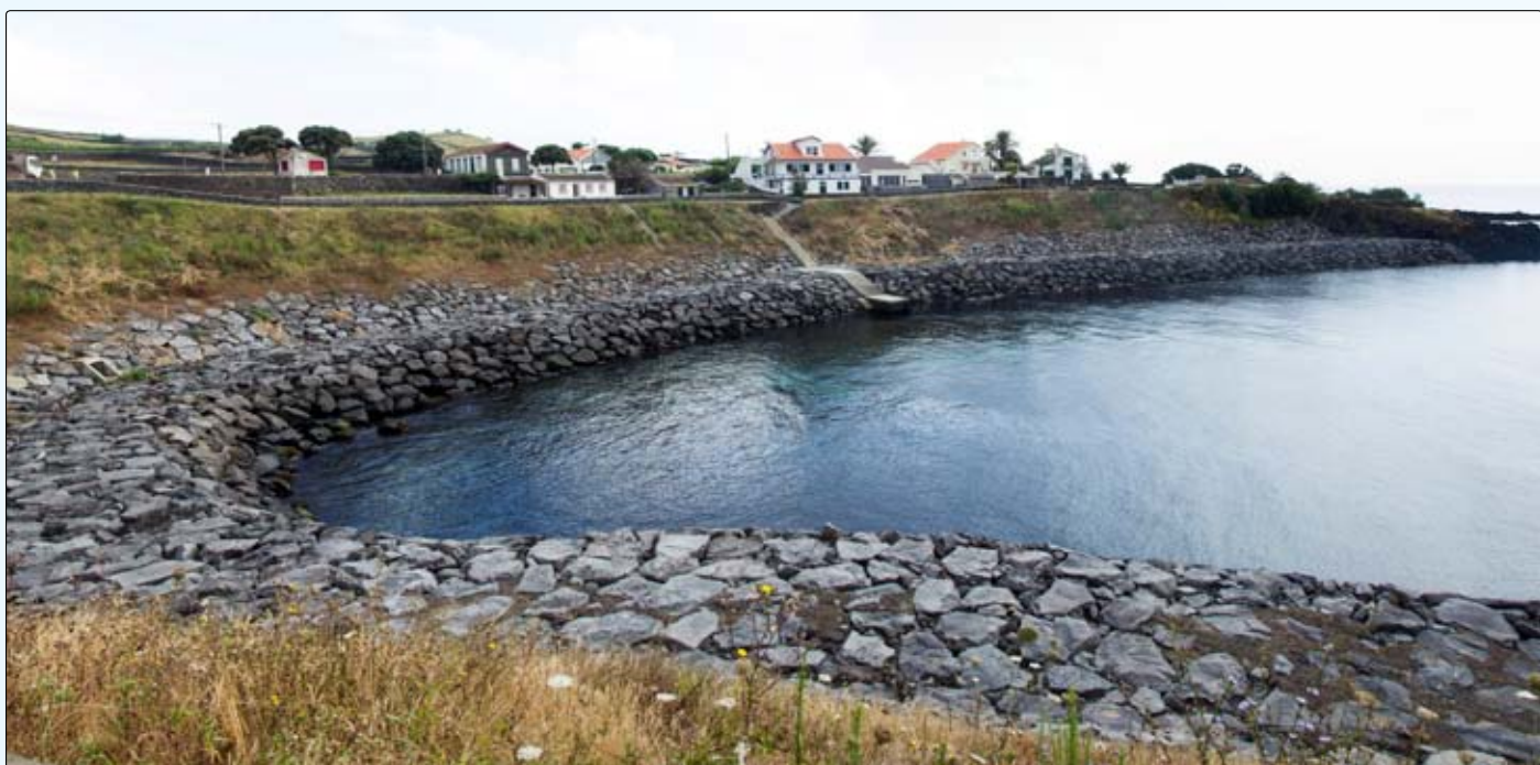
Prolongamento da proteção da orla costeira até ao Pesqueiro do Trigo
