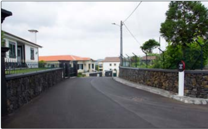
Pavimentação e alargamento da Canada de Baixo
