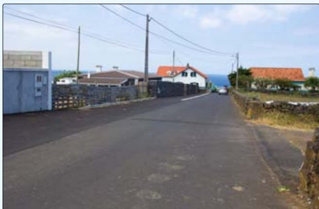
Pavimentação de sobras na Rua da Caldeira
