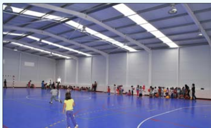
Construção do Pavilhão Desportivo
