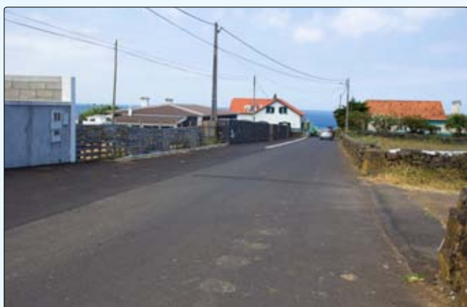
Pavimentação de sobras na Rua da Caldeira
