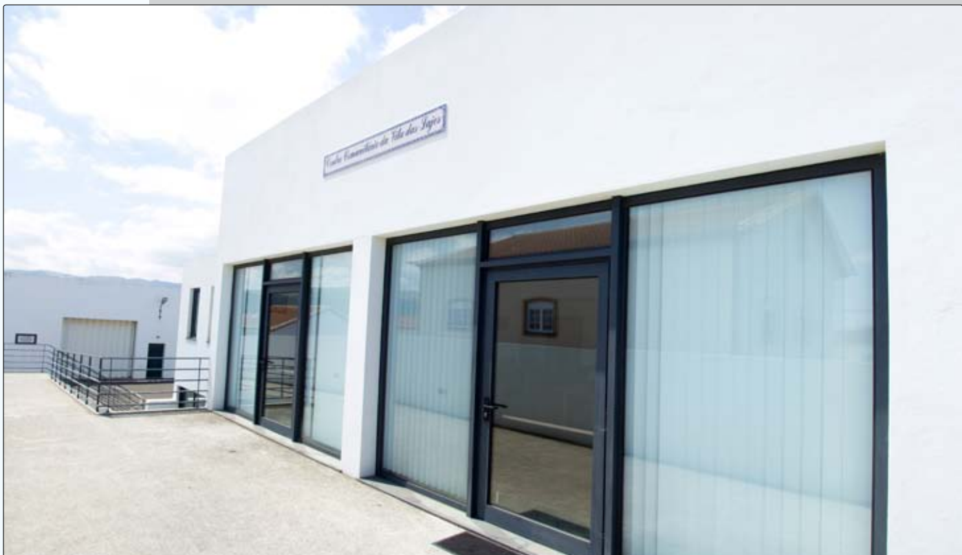
Construção do edifício Intergeracional da Vila das Lajes
