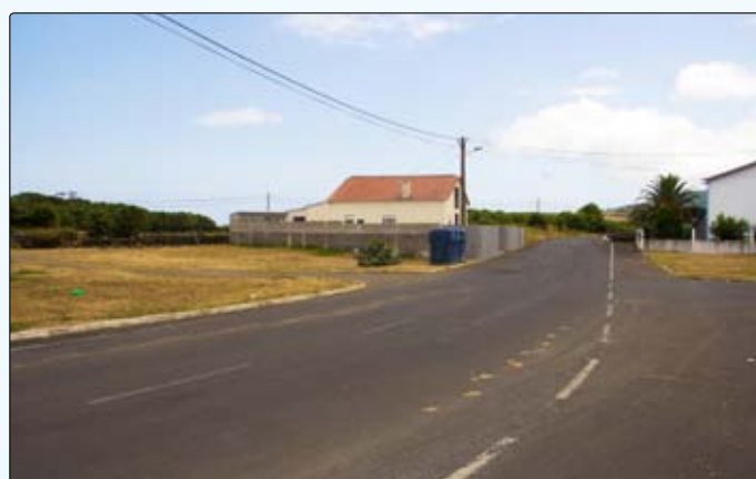
Pavimentação de sobras na Rua do Lajedo
