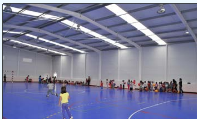
Construção do Pavilhão Desportivo
