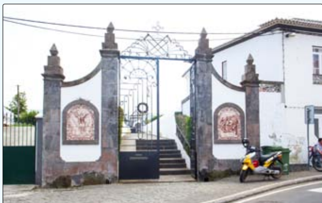
Novo portão do Cemitério
