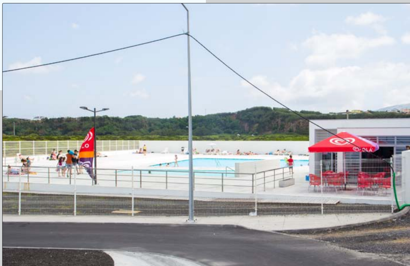
Construção do Passeio Marítimo e Piscina da Caldeira da Vila das Lajes
