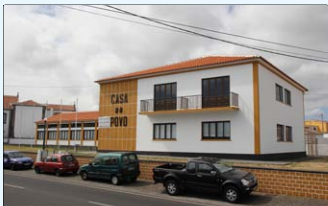
Ampliação da Casa do Povo
