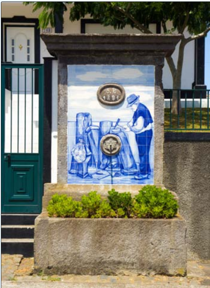
Restauro e colocação de painéis de azulejos nos chafarizes da Vila
