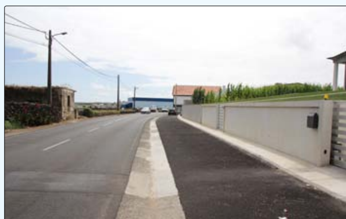
Pavimentação de sobras na Rua Padre Lourenço Ávila
