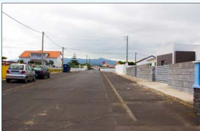
Pavimentação de sobras na Rua São Miguel Arcanjo
