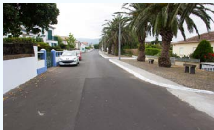
Pavimentação de sobras na Aldeia Nova
