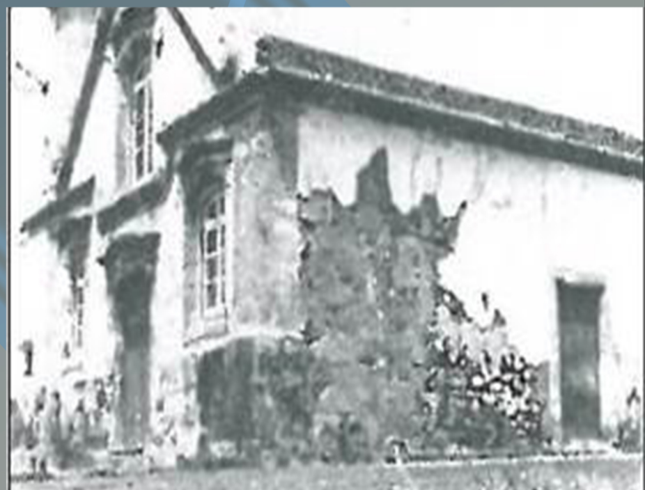
SISMO DE 1 DE JANEIRO DE 1980, IGREJA DAS QUATRO RIBEIRAS
